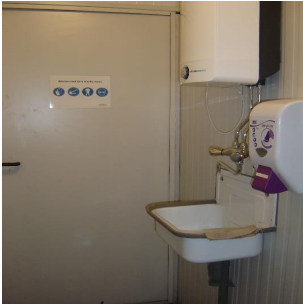
Voorbeeld van eenvoudige wasgelegenheid, en markering op de deur dat daarachter de RCF-zone is.
