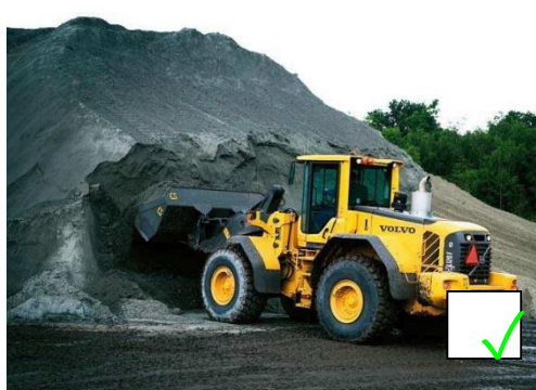
Afgraven kleidepot boven maaiveld: geen instortgevaar
