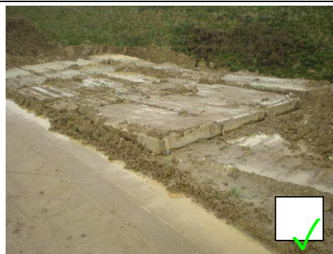
Rijplaten om gewicht vervoersmiddelen te verdelen
