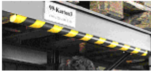
Stootbanden met waarschuwingssignalering
