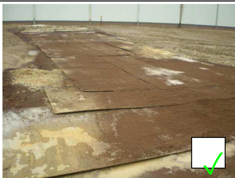
Rijplaten om gewicht vervoersmiddelen te verdelen
