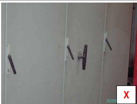
E-kasten bereikbaar voor onbevoegden
