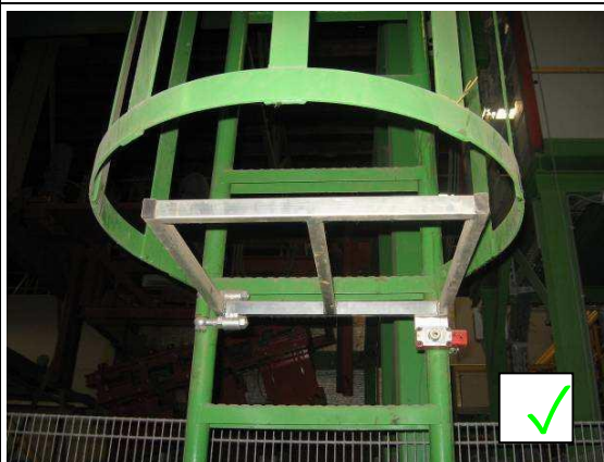
Kooiladder afgeschermd met zekerheidsslot.
