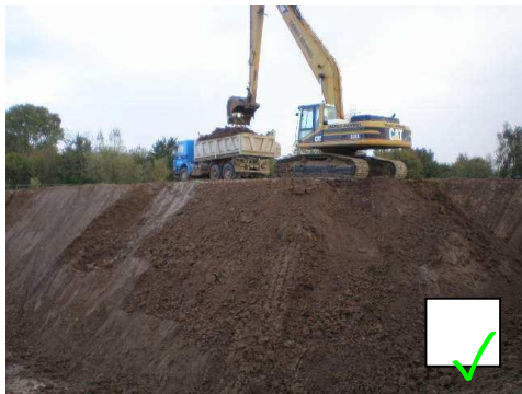
Kleidepot onder maaiveld: stabiele ondergrond
