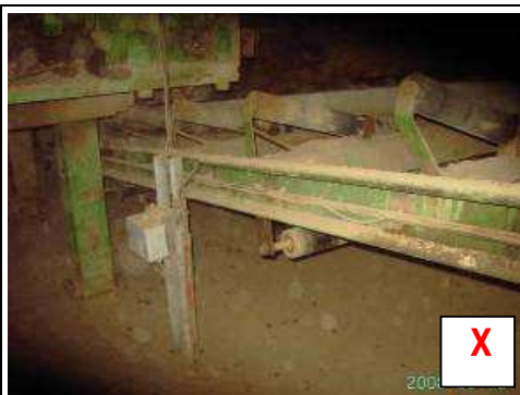
Rol opgaande zandband onvoldoende afgeschermd
