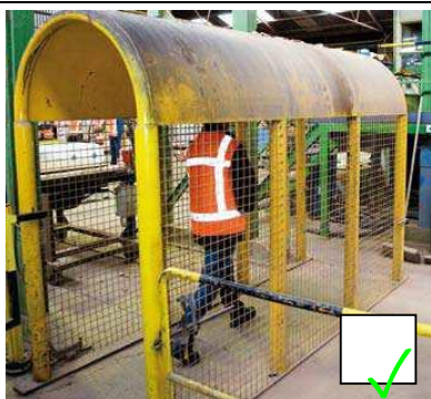
Afscherming looppad onder hijswerkzaamheden
