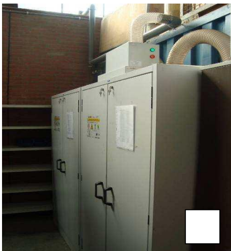
Milieukast met afzuiging voor opslag kleine verpakkingen gevaarlijke stoffen. Op de deur veiligheidssignalering en inhoudsopgave stoffen
