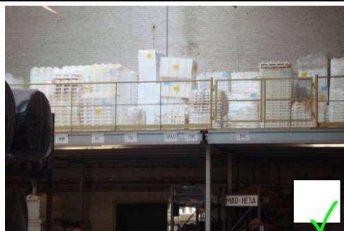
Entresol met hekwerk en gesloten doorgiftepunt
