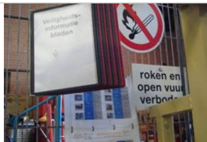
Veiligheidsmarkeringen bij toegang tot oliedrumopslag.
