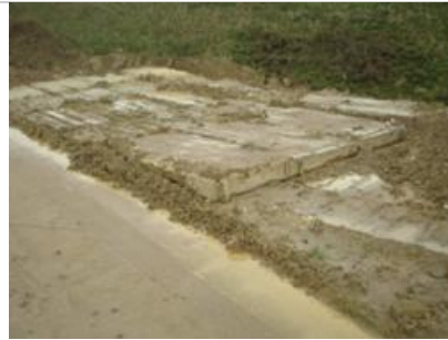
Rijplaten om gewicht vervoersmiddel te verdelen
