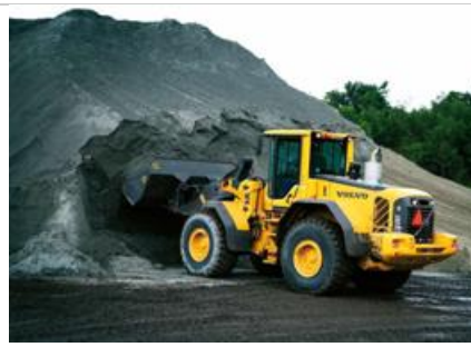
Afgraven boven maaiveld: geen instortgevaar
