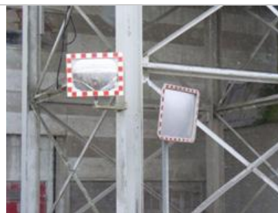
Hulpmiddel: verkeersspiegel voor beter zicht op gevaarlijke kruispunten en bij onoverzichtelijke situaties
